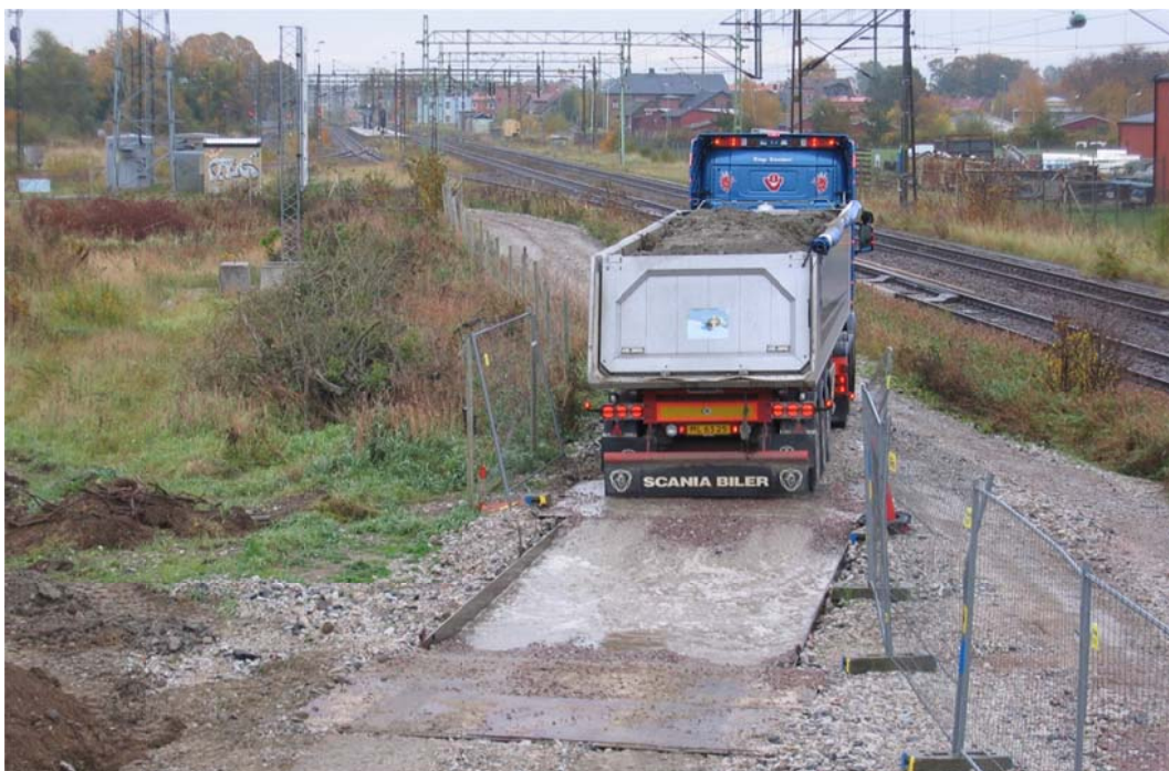
Figur 20. Lastbil med förorenad jord på väg mot Landskrona. Lastbilen har just passerat hjultvätten. Vid utfarten från arbetsområdet täcktes flaket.
