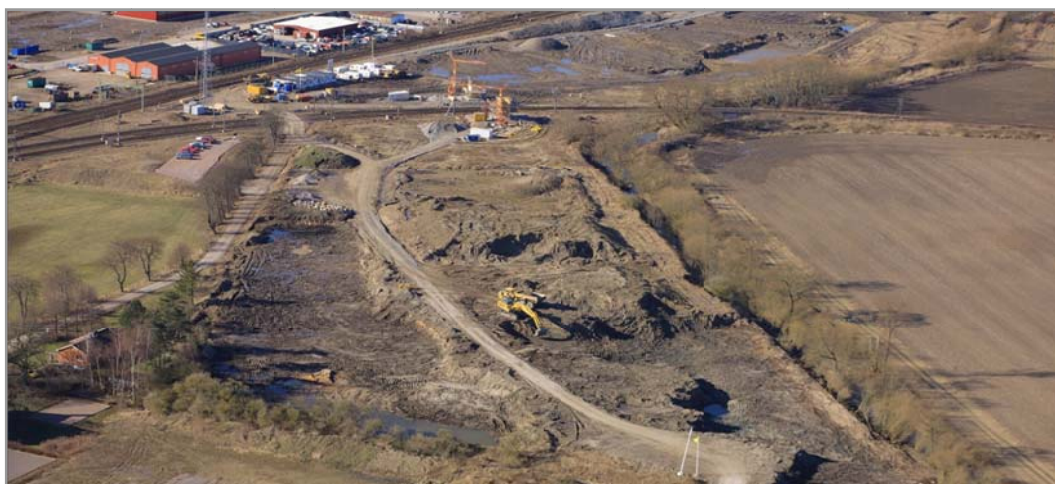
Figur 24. Flygfoto över upplagsområdet i förgrunden. Återfyllnadsarbete inom saneringsområdet pågår i bakgrunden, väster om upplaget (april 2009). Foto: Perry Nordeng.
